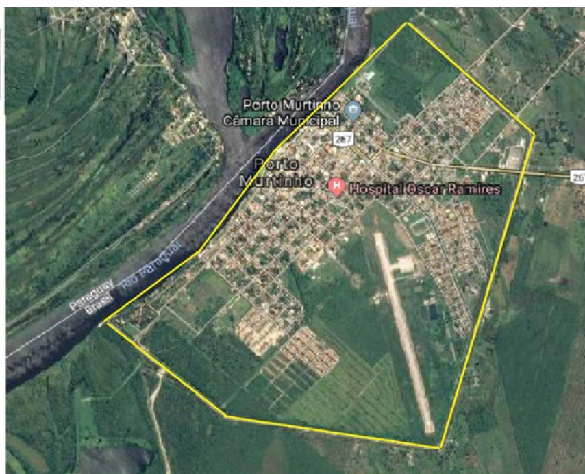
Figura 22 – Imagem aérea do dique em Porto Murtinho-MS Fonte: Derlei João Delevatti (2020).
